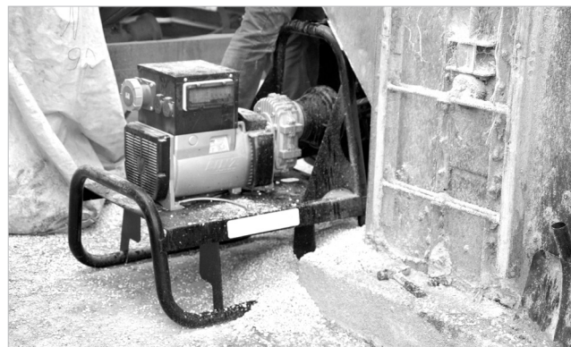
✓ Забезпечити роботу сушарок вдалося завдяки придбанню 30-кіловатного генератора.
